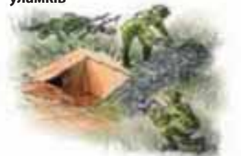
Наостанок виготовляється і встановлюється для закриття окопу люк
